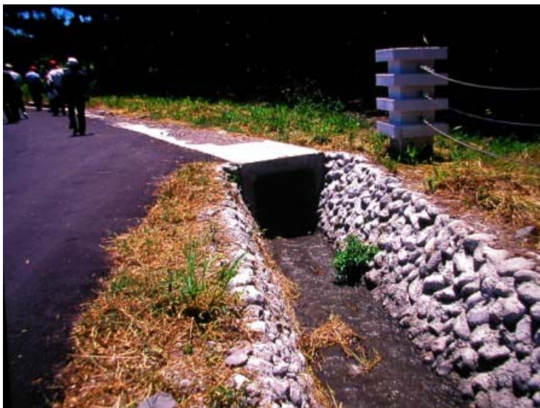
圖二：太麻里分所的圍牆及水溝工程。
